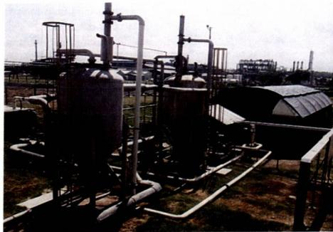
Componentes del sistema. Biofiltro industrial en la compañía Sucomiles. La derecha, detalle de los despojadores H<sub>2</sub>S.
