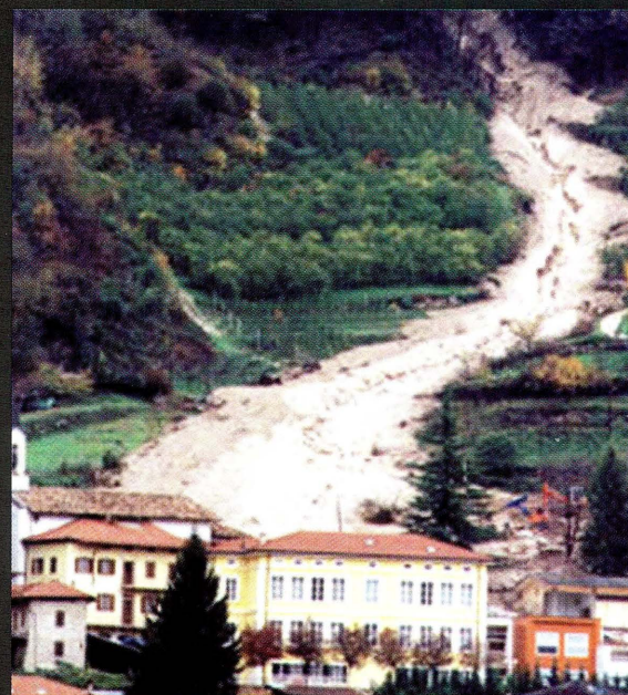
Deslizamientos en los Apeninos, Italia
