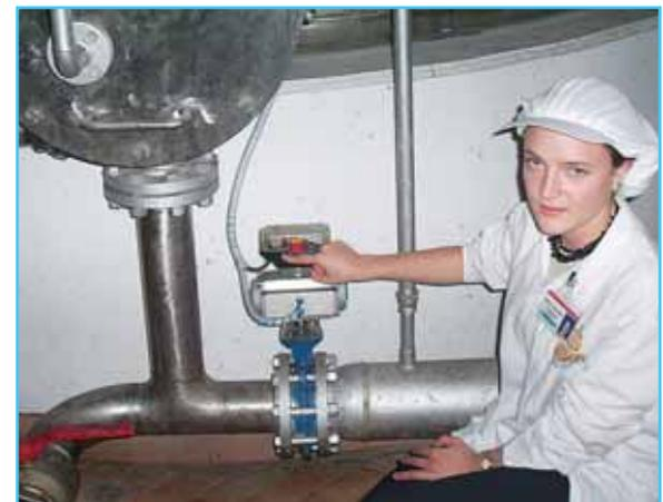
Foto 2 **Proceso de Coolmix.** Sistema automático de apertura y cierre de válvulas por medio de un procesador central.
