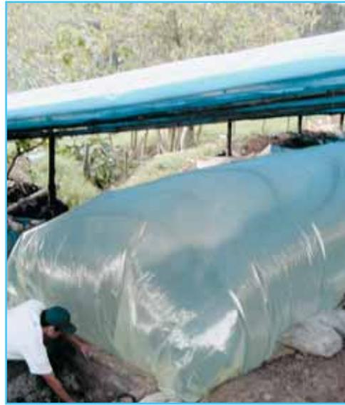
**Fotos 3-4** A la izquierda. **Biodigestor de 10 m<sup>3</sup> en geomembrana de PVC.** Escuela de la vereda de Alto Bonito, Manizales, Caldas. A la derecha. **Biodigestor plástico tipo CIPAV para tratamiento de aguas de origen porcino de 15 m<sup>3</sup>.** La Quisquina, Palmira, Valle del Cauca.
