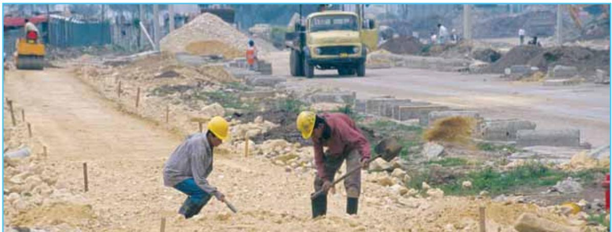
Foto 1 Mejoramiento de la capacidad estructural del material. Colocación del producto químico.
