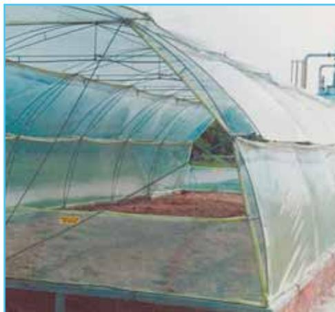
Fotos 4-5 Biofiltro. Entrada, interior del biofiltro y detalles de la cubierta tipo invernadero.
