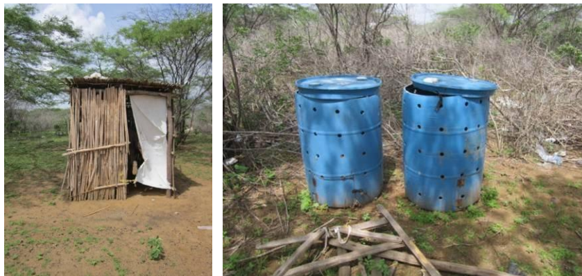
Foto 3.40 Caseta en yotojoro y tanques de acumulación de material retenido
