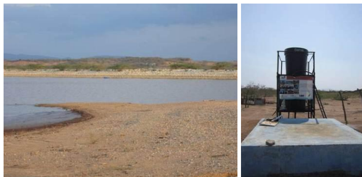
Foto 3.47 Formas de abastecimiento de agua: reservorio y torre de tratamiento con cisterna bajo
