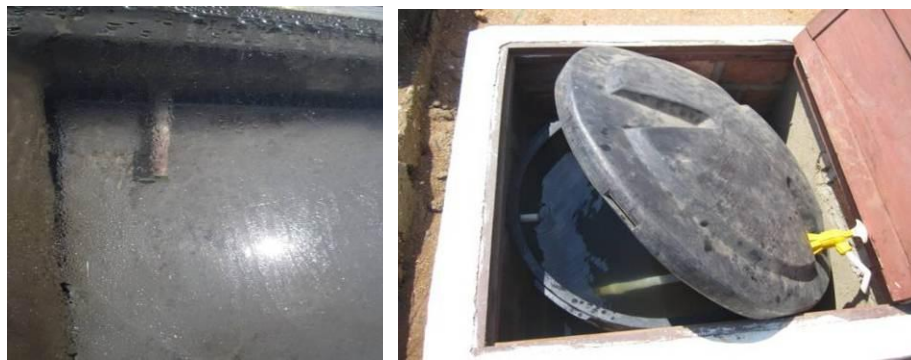
Foto 3.55 Bandeja de destilación solar y tanque de acumulación del agua destilada
