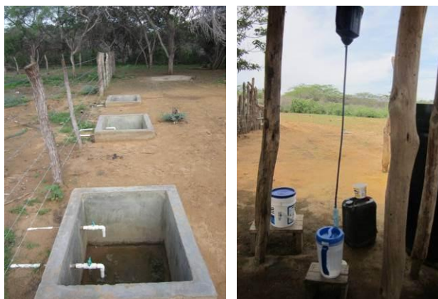
Foto 3.38 Puntos de toma de agua y filtro casero en funcionamiento
