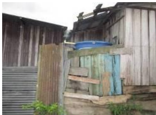
Foto 3.6 Aprovechamiento de agua lluvia barrio Metropolitano
