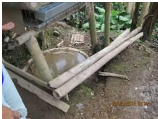
Foto 3.22 Tanque séptico que descarga aguas arriba de la zona de captación
