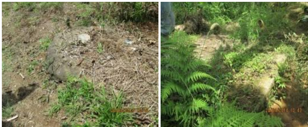
Foto 3.27 Cámara de inspección alcantarillado y tanque séptico comunitario
