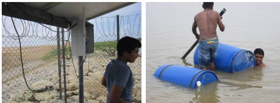
Foto 3.48 Tablero de panel solar y flotador bomba
