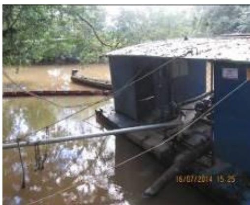
Foto 3.4 Sistema de bombeo en quebrada negra y barreras control contaminación en bocatoma
