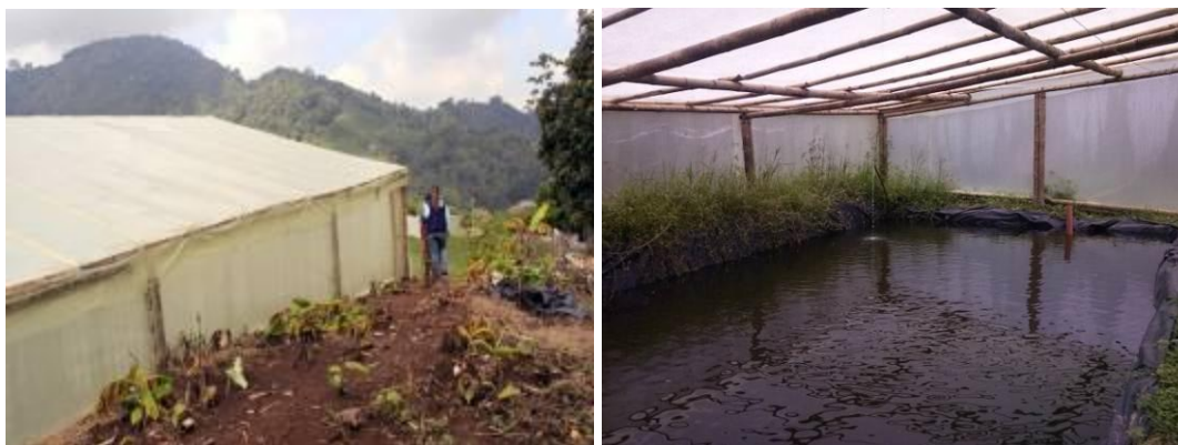
Foto 3.29 Estanques construidos con cobertura
