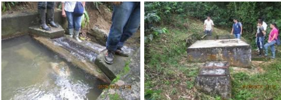
Foto 3.17 Captación y desarenador Acueducto Charco Hondo
