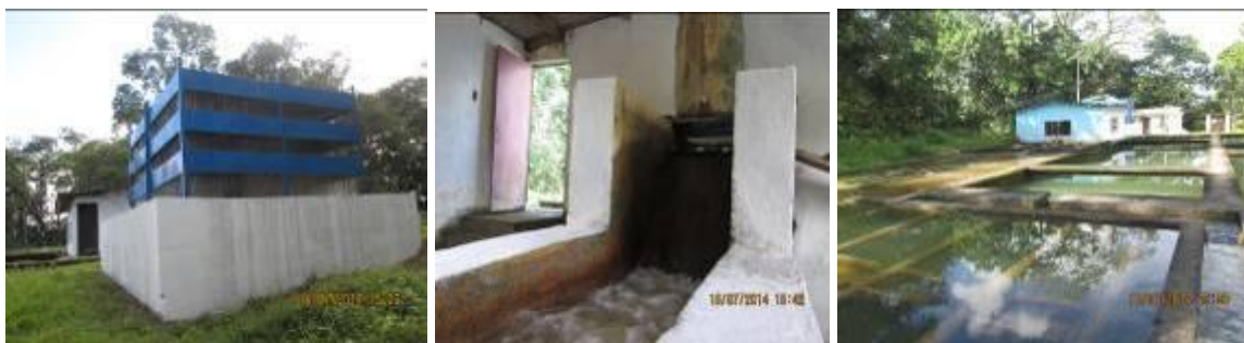
Foto 3.5 Planta de tratamiento Municipal
