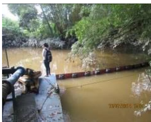
Foto 3.4 Sistema de bombeo en quebrada negra y barreras control contaminación en bocatoma
