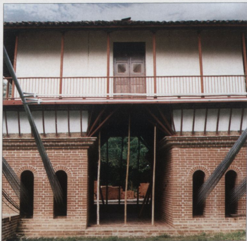
Casa de Máquinas del Puente de Occidente. Fotomontaje Cristina Salazar
