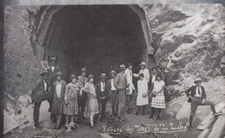
Túnel de La Quebra. Foto: Melitón Rodríguez. Biblioteca Pública Piloto de Medellín
