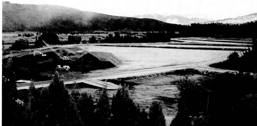
PATIO DE ACOPIO TÉRMICO.
