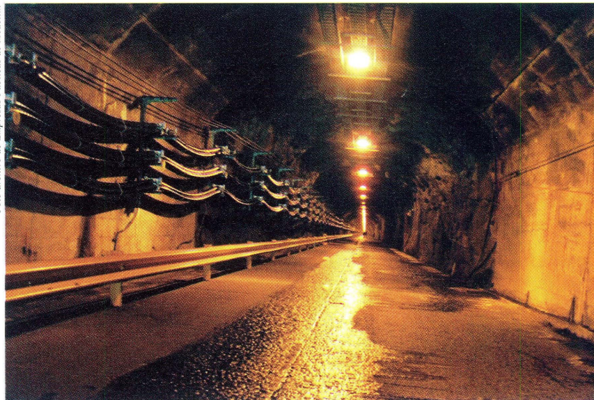
▲ TÚNEL DE ACCESO A LA CASA DE MÁQUINAS DE LA CENTRAL HIDROELÉCTRICA LA TASAJERA.
