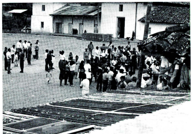
Generador fotovoltaico (240W-pico) que suministra energía eléctrica para iluminación y comunicaciones en la comunidad indígena del Yunguillo (Putumayo).
